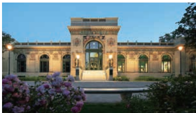
ハンガリー千年の家は公園で最も古い建物のひとつ 改修後はコンテンポラリーアートの展示スペースとして生まれ変わった。
