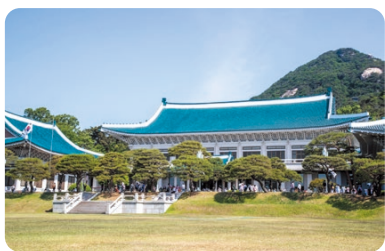
2022年から一般開放された青瓦台
