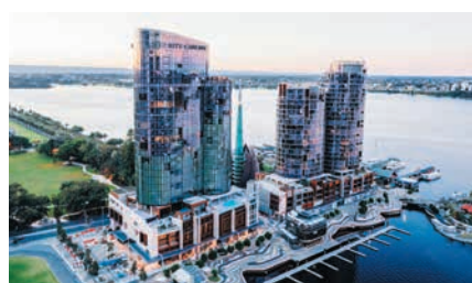
エリザベス・キーを見下ろすリッツ。至近に新ホテルも建設中
