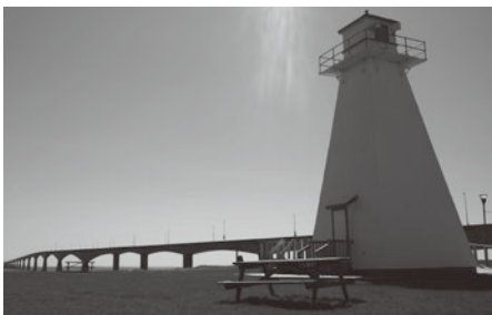
島と本土を結ぶコンフェデレーション・ブリッジ。全長12.9kmで、1997年に完成した。島側から本土側を眺める
